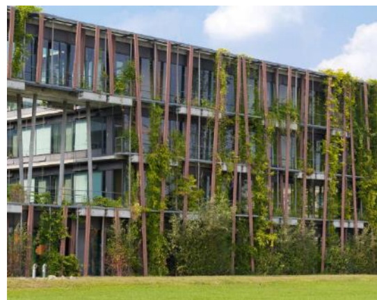
Zöldhomlokzat futtatott növényekkel Forrás: Zöldinfrastruktúra füzetek
