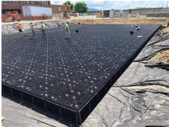
Szikkasztóládák jövőbeni parkolófelület alatt (Forrás: https://www.aco.hu/termek/csapadekviz-kezeles/stormbrixx-szikkaszto-rendszer )
