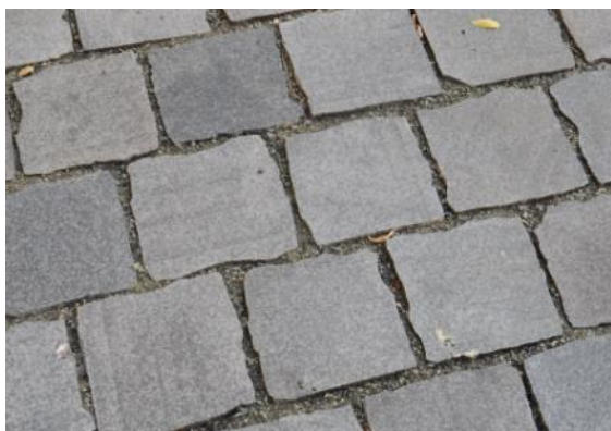
Áttört szegély és hajlékony alapozással épült elemes burkolat (Forrás: Zöldinfrastruktúra füzetek)
