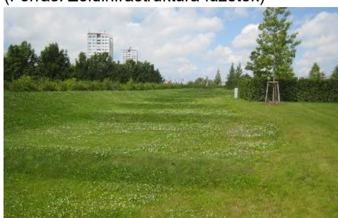
Szikkasztóárok (Forrás: Zöldinfrastruktúra füzetek)
